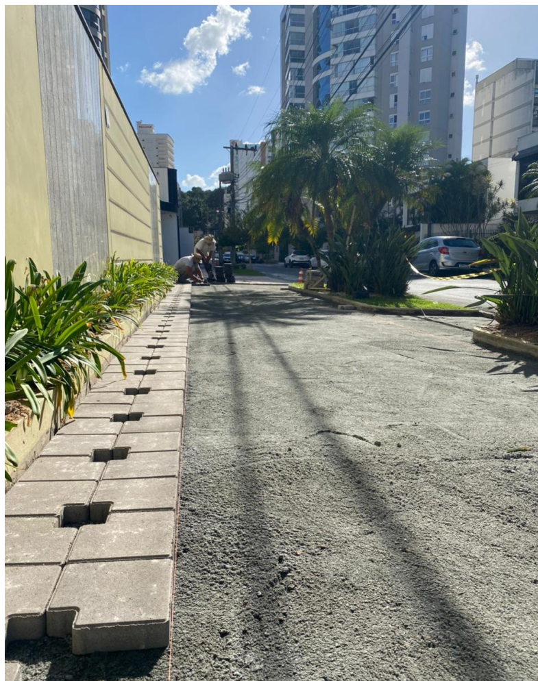
Exemplo execução Passeio (piso com toseto) sobre pó de pedra.
