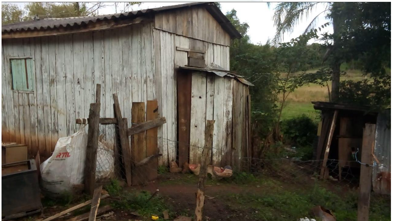
Foto 03/04 - Local onde a Obra será executada
