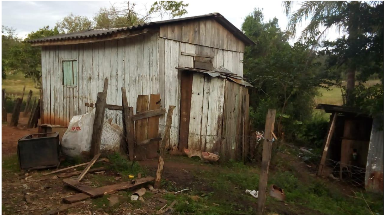
Foto 02/04 - Local onde a Obra será executada
